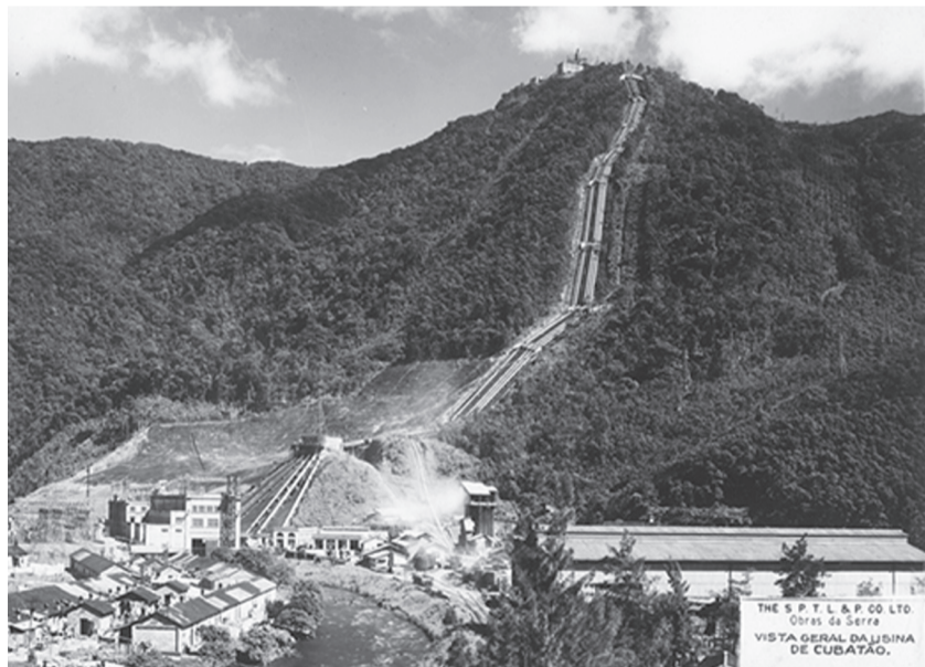
Vista geral da Usina Henry Borden, de Cubatão. 1948. Foto: acervo da Fundação Energia e Saneamento
